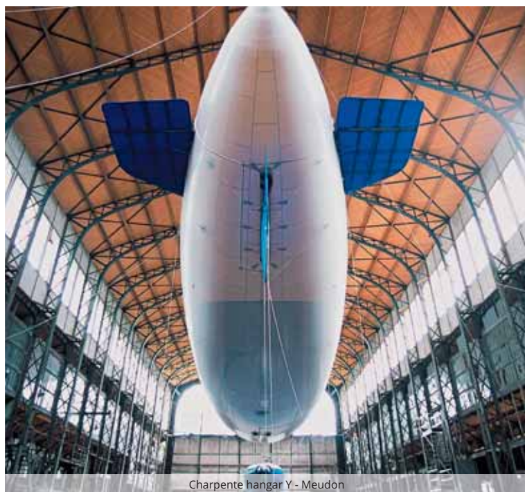
Charpente hangar Y - Meudon
