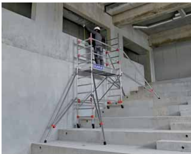
AL165 - Installation en dénivelés (dénivelé maxi 1,00 m)
